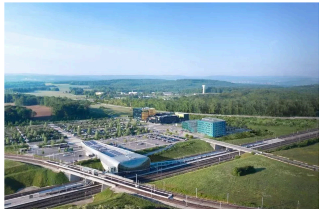
Le site de la Jonxion à Meroux-Moval avec la gare au premier plan.
